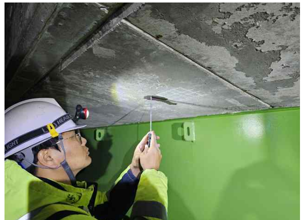
탄산화깊이 측정 현황
